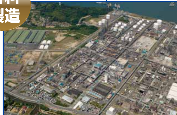
日本ゼオン水島 COP 製造プラント (岡山県倉敷市)
